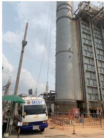
ปล่องระบายอากาศของ HRSG
